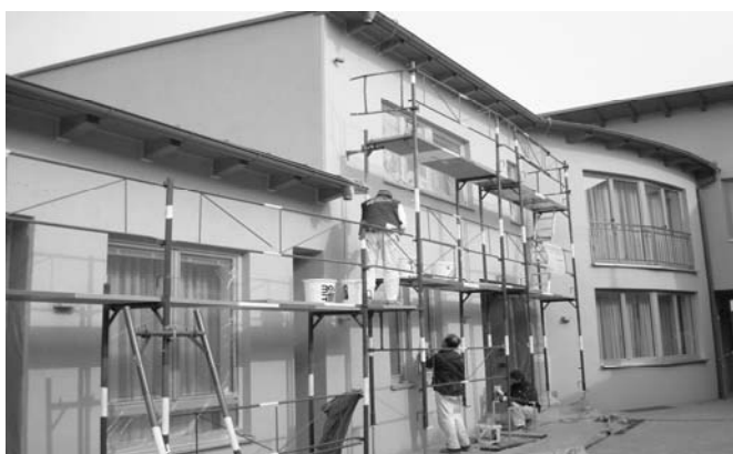
Mängelbehebung an der Fassade am 13. März 2008
